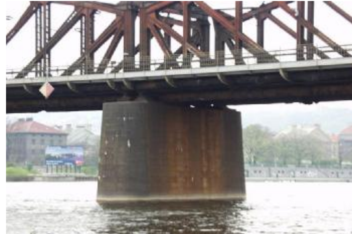
Železniční most na Výtoni
